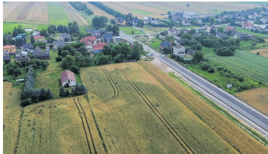
Tychów Stary - początek remontowanego odcinka
